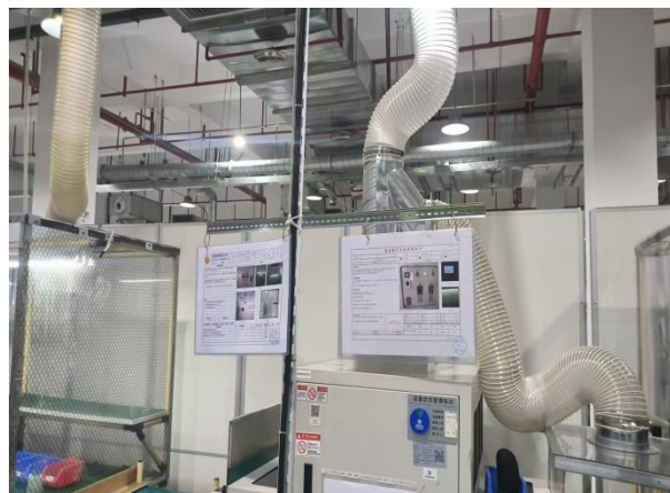
废气收集集气罩
