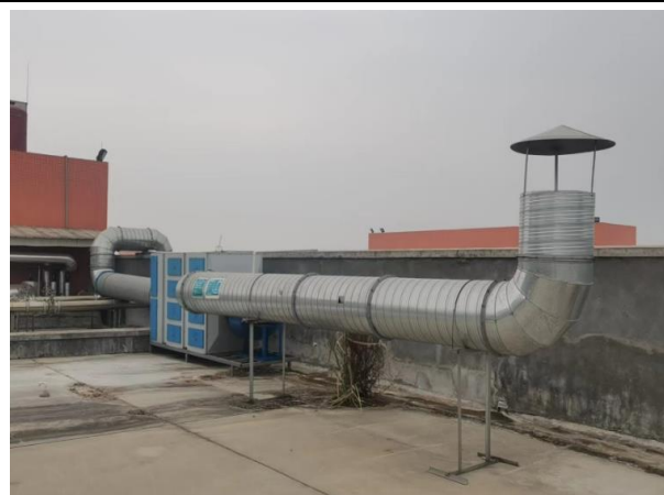
“布袋除尘器+两级活性炭吸附装置”及排气筒
