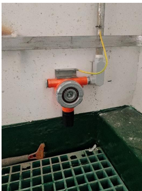
危废间地沟、漏液监测系统及门槛
